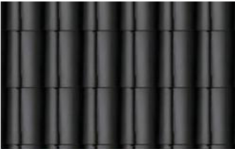
Daken: donkere kleur dakpannen
