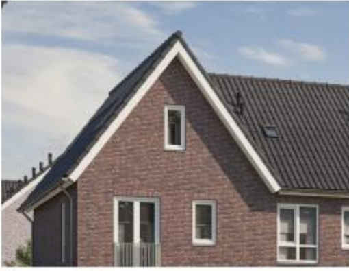
Dwarskap met witte dakrand
